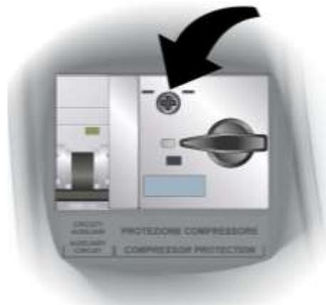
**Fig. 14:** Effettuare la taratura del salvamotore in base all'assorbimento rilevato. In ogni caso il valore impostato non deve essere superiore a quello massimo previsto dal costruttore del compressore.
